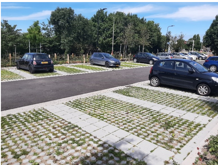
Figuur 1 Toepassing waterdoorlatende grasbetontegels in parkeervakken op Station Rodenrijs
