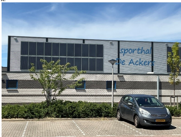
Figuur 1 Verticale zonnepanelen op Sporthal de Ackers
