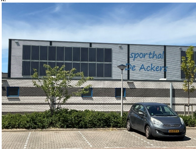
Figuur 1 Verticale zonnepanelen op Sporthal de Ackers
