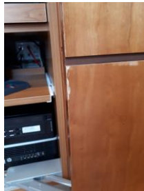
Beschadiging door stoten met bureaustoel
