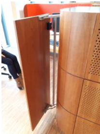
Deur draait ver open en belemmert
