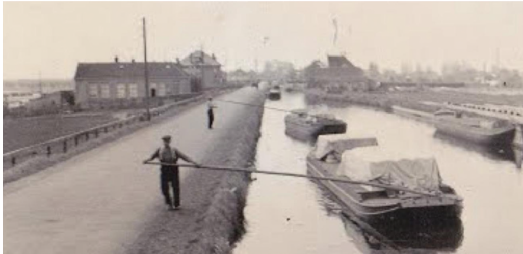
Historische foto vaart langs de dijk als verbinding naar veiling
